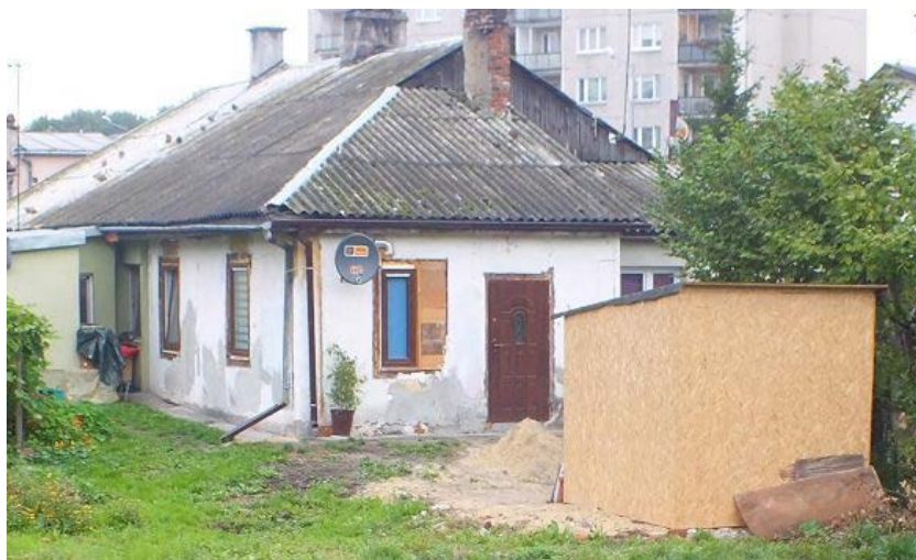
Zdjęcie 7. Widok pokrycia dachowego z wyrobów zawierających azbest w dolinie Huczwy w Hrubieszowie
