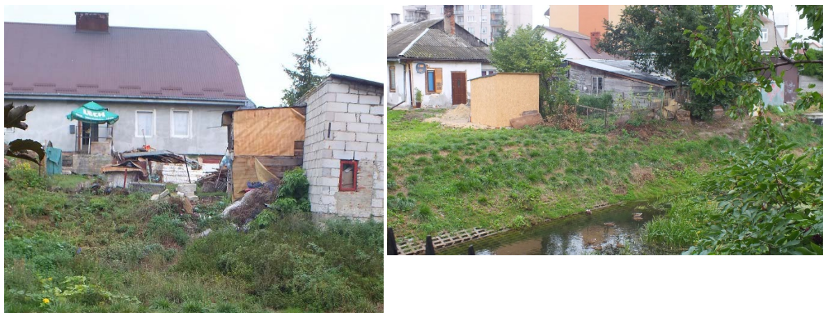
Zdjęcie 10. Widok substandardowej zabudowy w dolinie k. Ulgi oraz rz. Huczwy w Hrubieszowie
