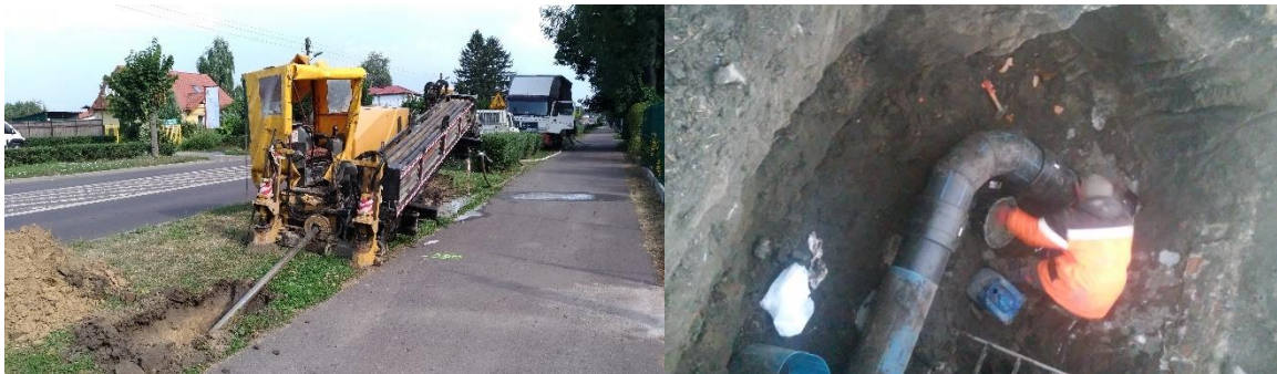
Rysunek 38 Modernizacja i przebudowa sieci wodociągowej w ulicy Zamojskiej od ulicy Piłsudskiego do skrzyżowania z ulicą Teresówką – dokumentacja fotograficzna
