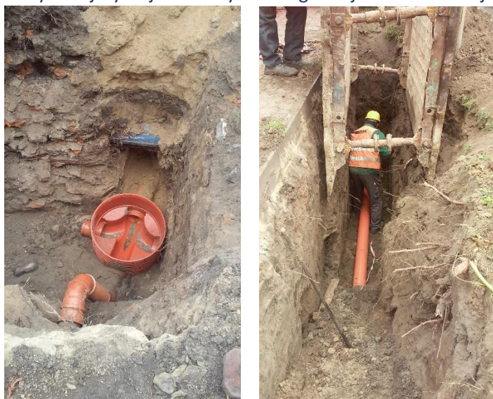
Rysunek 40 Przebudowa/modernizacja sieci kanalizacji sanitarnej w ulicy Narutowicza, Prusa, 27 Wołyńskiej Dywizji Piechoty AK i Pogodnej – dokumentacja fotograficzna
